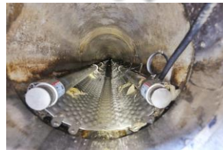
Abwasserwärmetauscher
